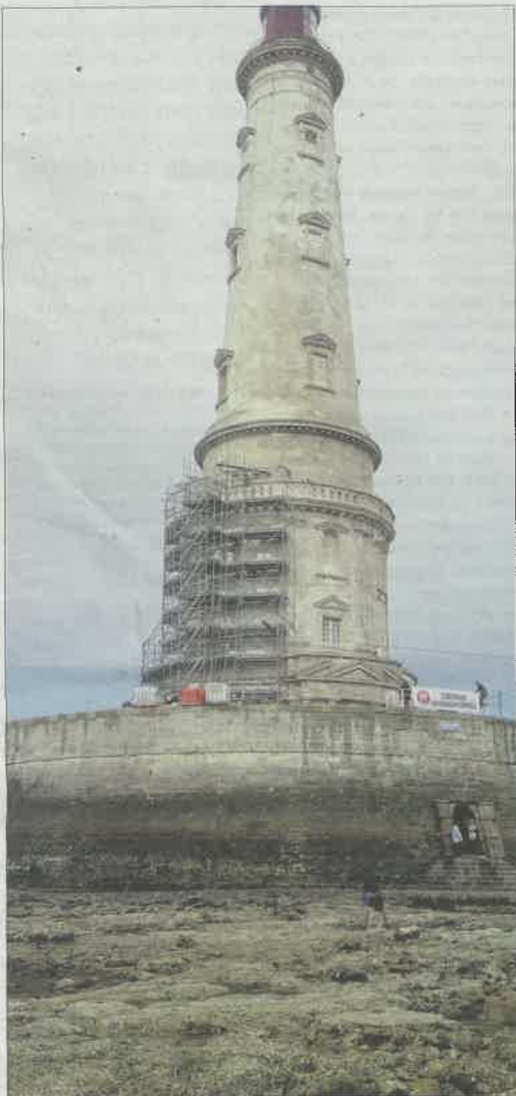
L'échafaudage sur la face Sud du fût du phare.
